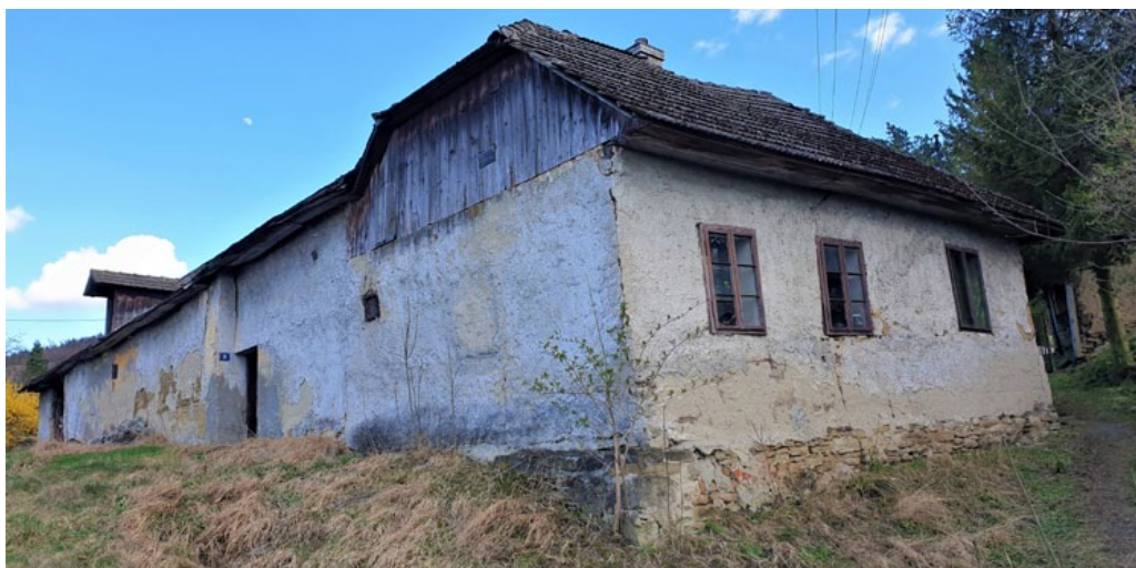
Obr. 7: Areál obytných a hospodářských budov čp. 19. V popředí nejstarší část – roubený dům v „kožichu“ (silná vrstva hliněné mazaniny promíchané s plevami, řezankou) s hákovou dispozicí. Foto Z. Krajcar.
